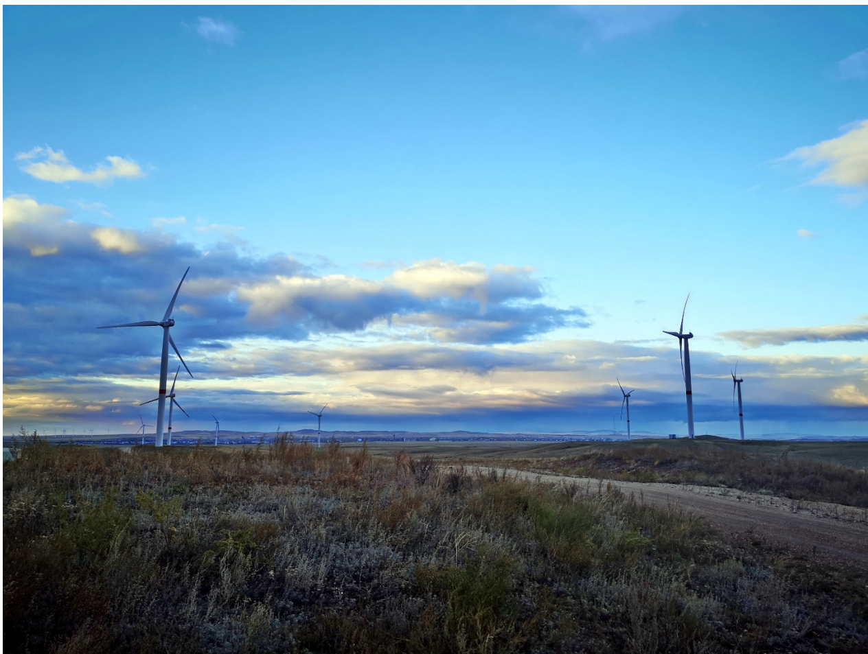
Рисунок 1. Общий вид ветропарка Ерейментау.
