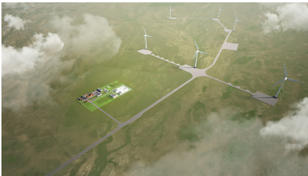
Рисунок 1. Общий вид ВЭС «Астана EXPO-2017»
